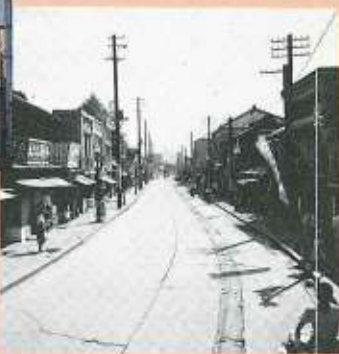
高松大通り(総構工事中) 昭和28年頃 ▲立川駅北口第一デパート前の通り/昭和30年頃
